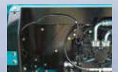
• Brandschutzwand zwischen Pumpen- und Motorraum
