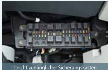
Leicht zugänglicher Sicherungskasten
